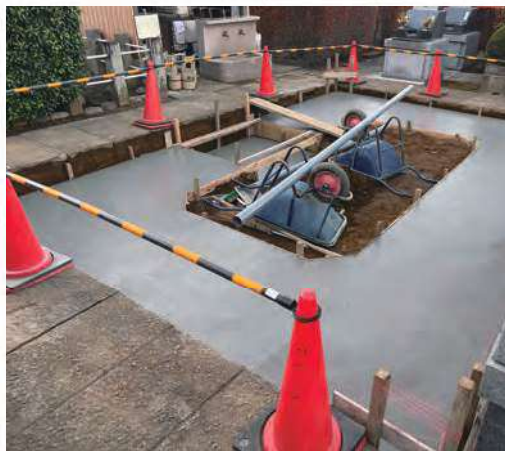
◆ 太い鉄筋とコンクリで土台は完ペキ!
